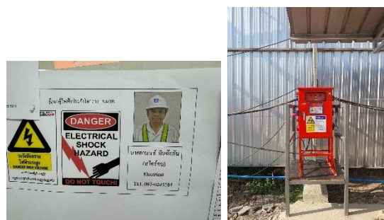
รูปที่ 23 ตู้ไฟฟ้าชั่วคราวและป้ายผู้ควบคุม
