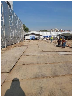
รูปที่ 37 วัสดุรองป้องกันการลื่นสะเทือนรองเครื่องจักร
