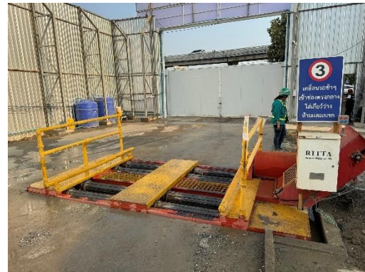
รูปที่ 14 เครื่องฉีดแรงดันสูงจุดล้างล้อ
